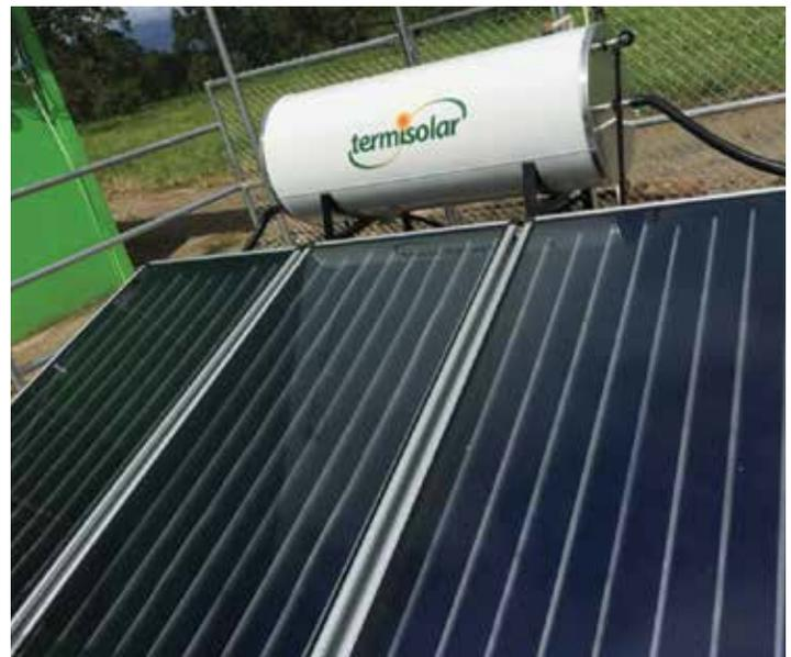
Sistema solar térmico termosifónico híbrido con resistencias eléctricas, instalado en la lechería de la Escuela Técnica Agrícola e Industrial de San Clara.
