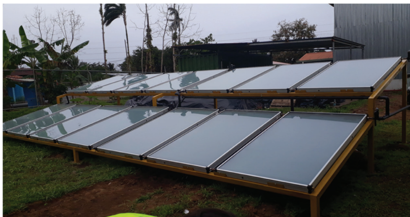
Figura 2. Sistema térmico solar híbrido forzado instalado en la planta procesadora de la Asociación de Productores de Pimienta de Sarapiquí para el escaldado de la pimienta verde. Fuente: Elaboración propia
