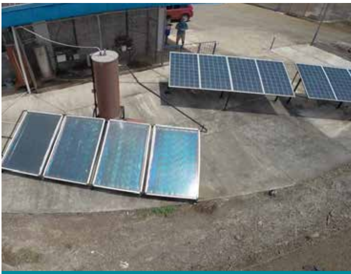
Sistema solar térmico termosifónico híbrido con resistencias eléctricas, de izquierda a derecha y sistema fotovoltaico de 2 K, montados en la lechería del Instituto Tecnológico de Costa Rica y que abastece a los laboratorios de Biocontroladores y Calidad de carne de la Sede Regional.
