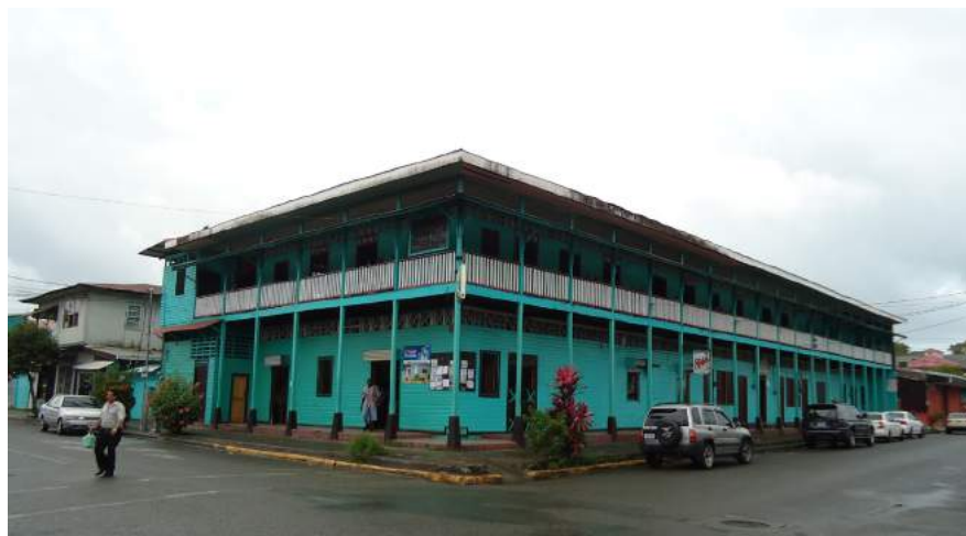
Figura 32. Edificio Black Star Line. Fuente: Elaboración propia con base en el trabajo de campo (28/02/2011).
