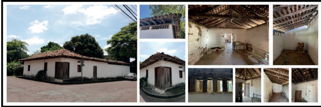
Figura 1. Fotografías internas y externas de la Casa de la Cultura de Liberia. Fuente: Proyecto “La construcción social del Centro Histórico de la ciudad de Liberia como un insumo para su gestión sostenible” del Instituto Tecnológico de Costa Rica
