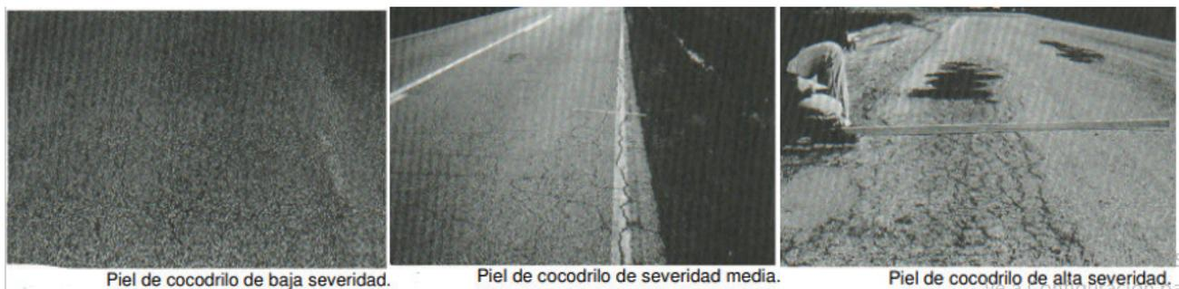
**Figura 4.** Niveles de severidad en piel de cocodrilo para carpetas asfálticas [16].
