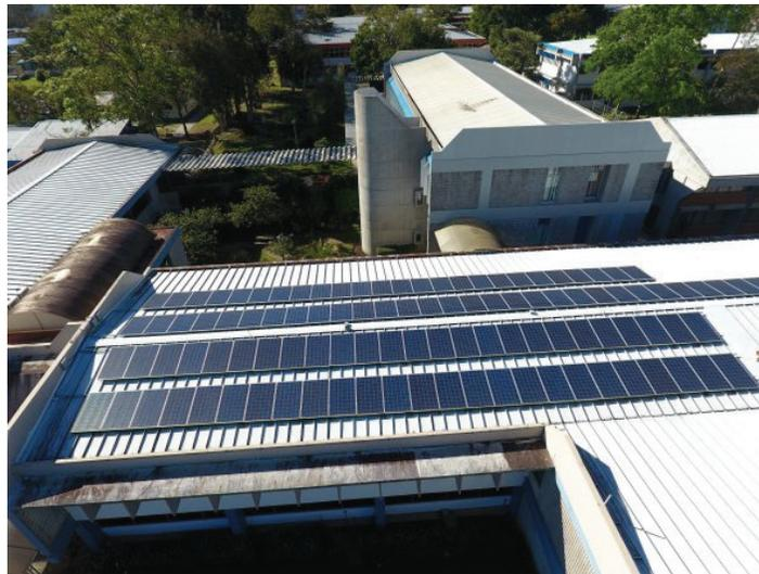
**Figura 1.** Sistema fotovoltaico conectado a red instalado en el Edificio A1 del Campus Central del Tecnológico de Costa Rica ubicado en Cartago, Costa Rica.
