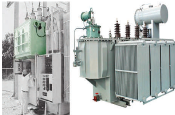
Figura 5. Disposición física del OLTC de tipo reactivo. Fuente. Adaptado de [15].
