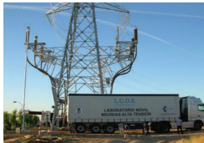
Figura 1. Generador resonante para ensayo de cable aislado de 220 kV.
