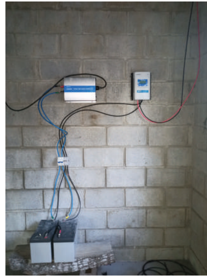
Figura 7. Sistema de control de paneles solares.
