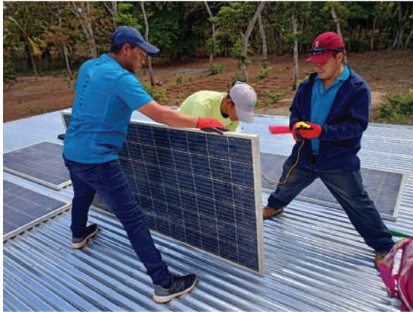
Figura 6. Instalación de sistema fotovoltaico.
