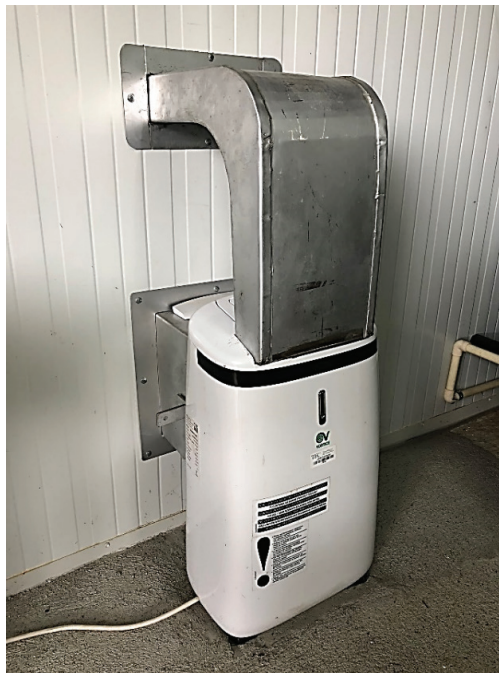
Figura 5. Instalación del deshumidificador portátil Deumido M20.
