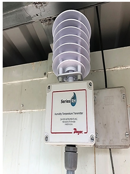
Figura 7. Instalación del sensor de humedad y temperatura RHP-2R11.
