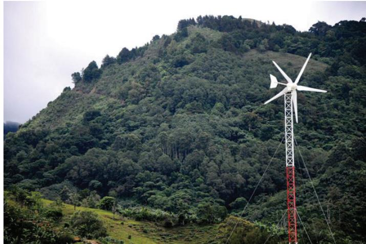
**Figura 3.** Turbina eólica de 3kW instalada en un entorno boscoso a 18 m de altura [20].
