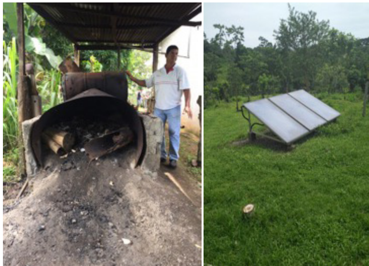
Figura 2. Antiguo sistema de calentamiento (caldera) vrs nuevo sistema fotovoltaico.
