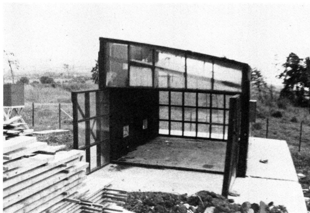
FIGURA 3: Secadora solar en construcción.
