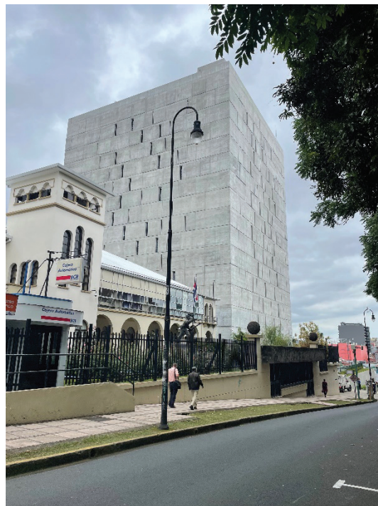
Figura 10. Vista edificios de la Asamblea Legislativa. Fuente: Laura Chaverri Flores, 21 de julio 2022.
