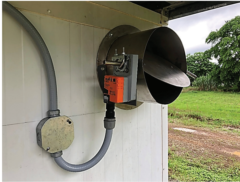
Figura 6. Instalación del actuador AMB24-SR en la escotilla del secador.
