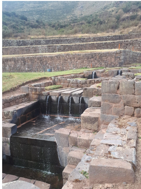
Figura 1. Acueducto Inca en Tipón, Perú.
