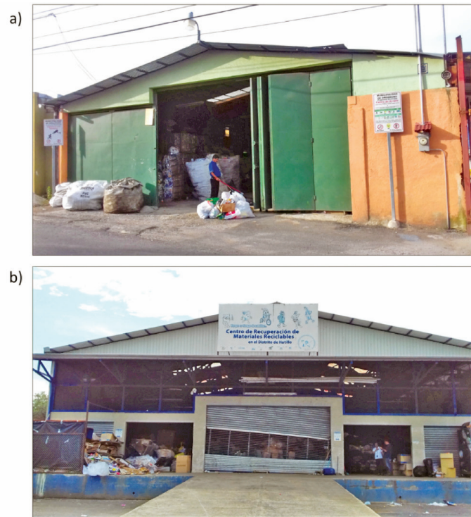
Figura 1. Instalación con un único acceso y sin muelle de carga (a) e instalación con entrada y salida separadas, así con como un muelle de carga (b).
