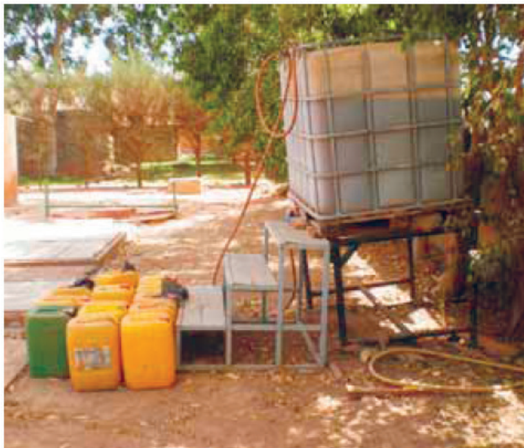
Figura 2. Tanques de almacenamiento de un metro cúbico. Fuente: [12]
