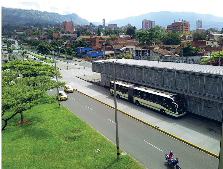
Figura 5. Metroplús en la transferencia de la estación Universidad del Metro.
