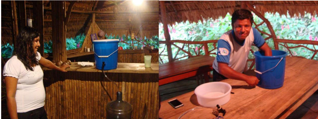
Figura 2. Instalación de filtro doméstico ACI en el albergue Koswak, a la izquierda filtro en funcionamiento.
