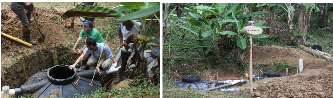
Figura 1. Instalación de biodigestor. A la derecha sistema de biodigestores instalado.
