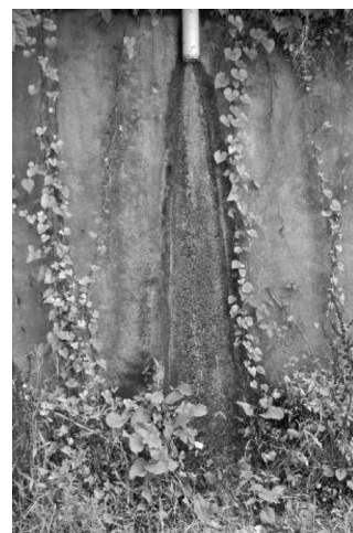
c) Rebalses de aguas negras provenientes de casas directamente en los terrenos
