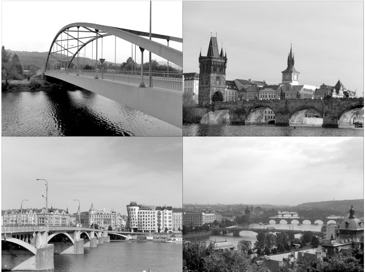
Figura 2. Puentes en República Checa. Fuente: Autor.
