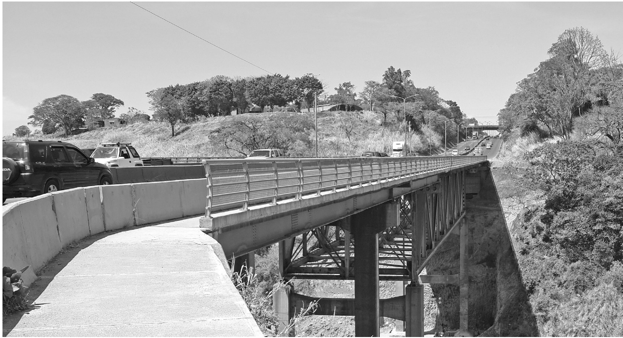
Figura 1. Vista del puente sobre el río Virilla, febrero 2014.
