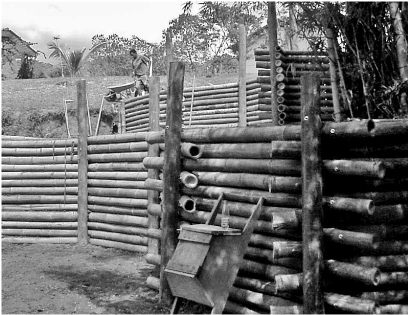
Figura 2. Muro a dos niveles con Guaduas rollizas entrelazadas.
