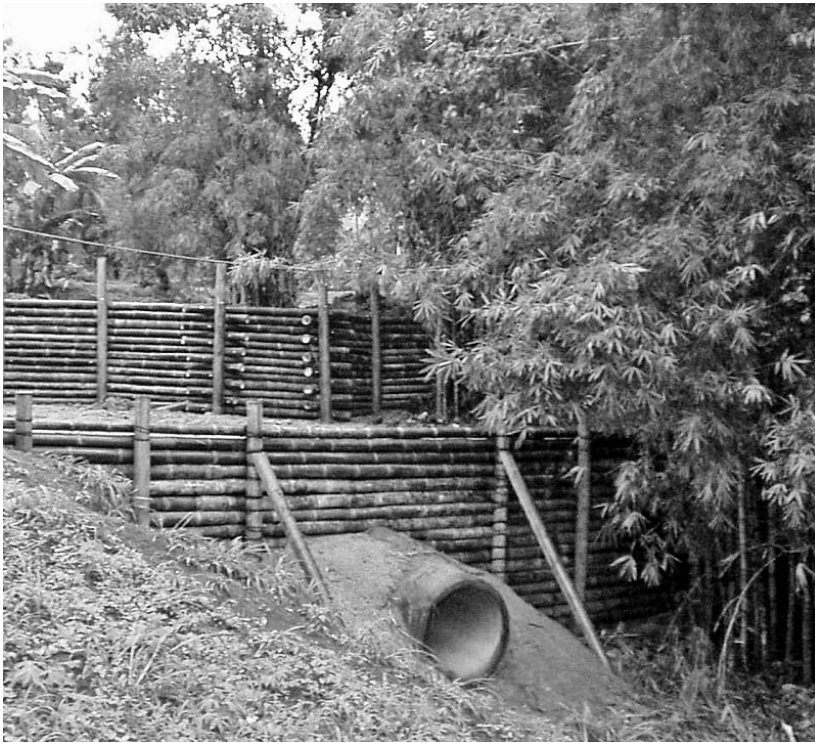
Figura 5. Tubería de gran diámetro para canalizar las aguas.
