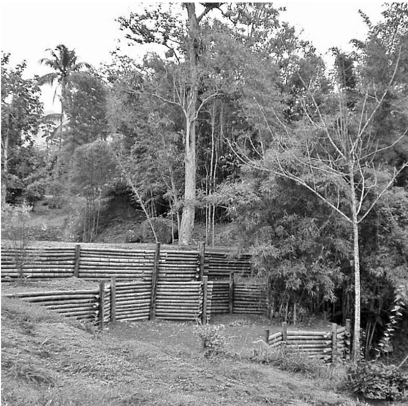
Figura 1. Muro de contención en tres terrazas de diferente nivel.
