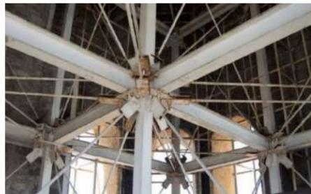
**Figura 2:** Estructura metálica tridimensional con oxidación en sus elementos. **Fuente:** fotografía tomada Máximo, R. (2017).
