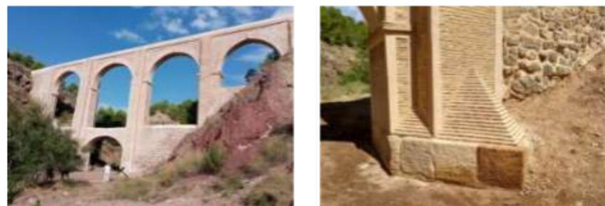
Figura 12: La arquería antes y después de la obra. Figura 13: Detalle del parteaguas
