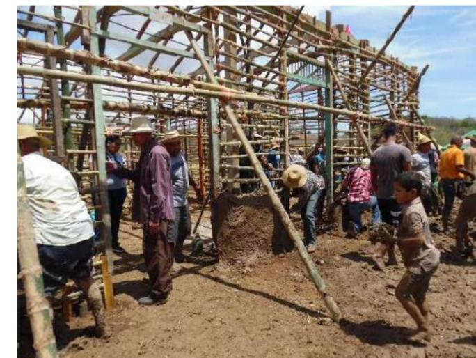
**Figura 1:** Junta de embarre de una vivienda tradicional de la región de Azuero construida en quincha. **Fuente:** Silvia Arroyo (2018).
