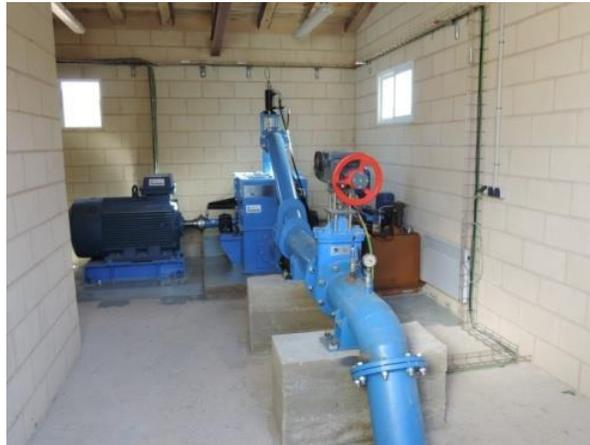
**Figura 2. Mini-turbina hidráulica Pelton con generador asíncrono**
