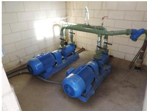
**Figura 3. Sistema de bombeo hidráulico con dos bombas centrífugas multietapa de 18.5 kW por unidad**
