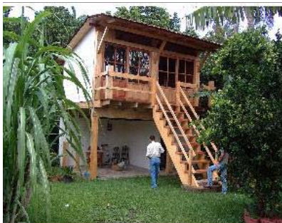
Figura 5. Vivienda de dos plantas construida con horcones y vigas laminadas y encoladas de melina ( Gmelina arborea ) por la compañía Maderas Cultivadas de Costa Rica.
