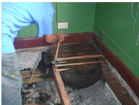
**Figura 2.** Nido de termita subterránea bajo un piso de madera.
