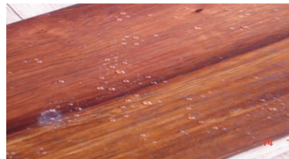
Prueba para analizar la impermeabilización del acabado.
