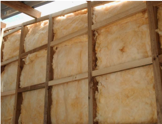
Instalación de fibra de vidrio
