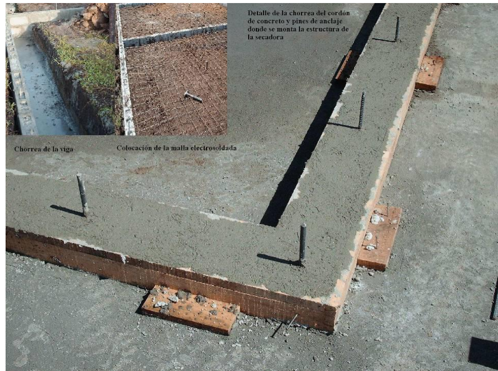
Detalle del cimiento y colocación de malla electro soldada
