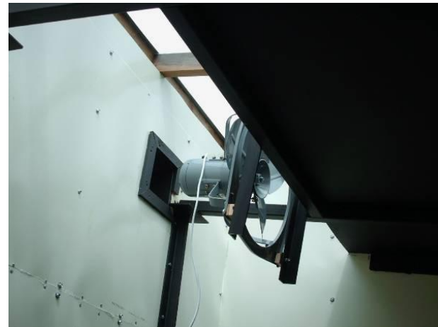
Ubicación e instalación e instalación del ventilador
