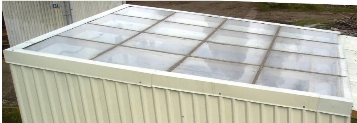
Vista superior del techo instalado
