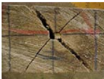
Rajaduras luego del secado por presencia de médula
