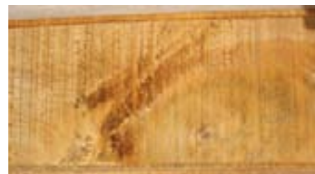
Grietas asociados a los nudos luego del secado
