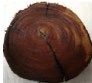
Penetración casi nula en madera de duramen (el color azul indica la penetración del preservante)
