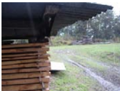
Protección de la madera ante la radiación solar y la lluvia en secado al aire
