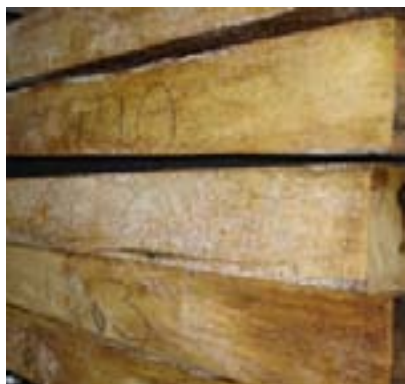
Desarrollo de hongos al mantener la madera almacenada con plástico en el proceso de difusión de sales de boro.
