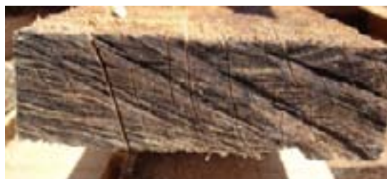
Rajaduras y grietas por cabeza en madera seca al aire
