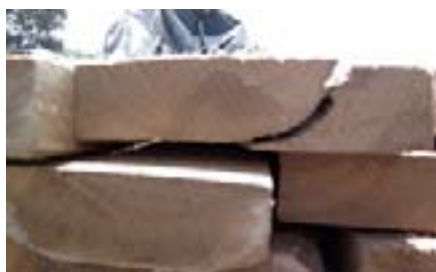
Rajaduras producidas por incidencia directa de rayos solares
