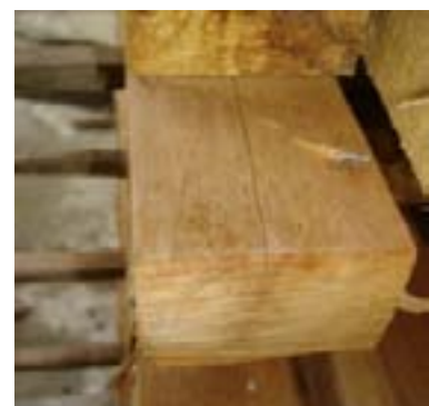
Desarrollo de rajaduras durante el secado al aire
