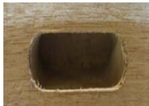
Escopleados de muy buena calidad
