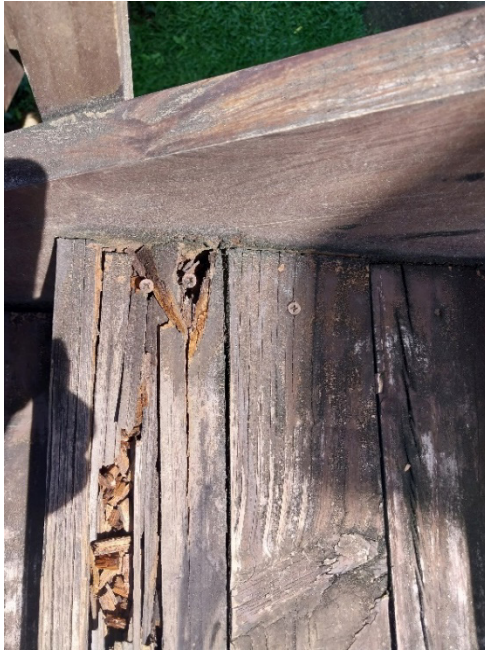
Deterioro en la madera de las escaleras (izquierda) y deterioro en paredes de madera por infiltración del agua en baños (derecha). Proyecto Don Sergio I, La Victoria, Río Frío, Sarapiquí, Heredia.
