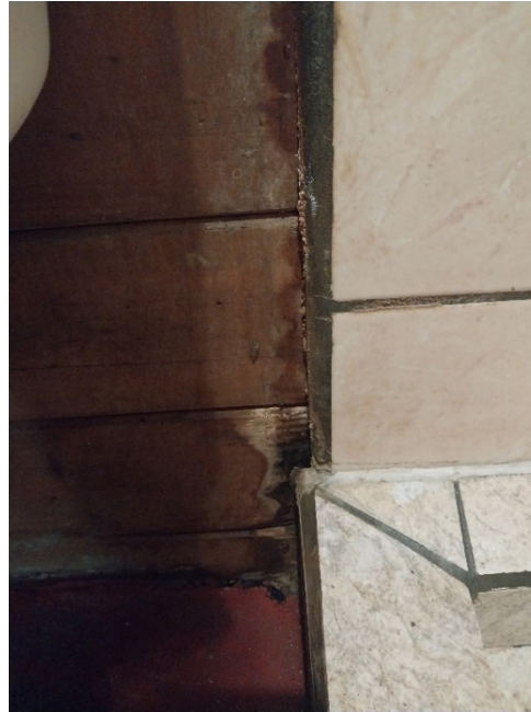
Deterioro en la madera de las escaleras (izquierda) y deterioro en paredes de madera por infiltración del agua en baños (derecha). Proyecto Don Sergio I, La Victoria, Río Frío, Sarapiquí, Heredia.
