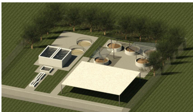
Figura 3. PTAR de Lodos Aerobios Granulares para el tratamiento de las aguas residuales de una urbanización en Costa Rica. a) Esquema de la planta; b) Diseño renderizado. Fuente: tomado con permiso de [7].
