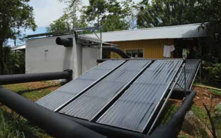
Figura 3. Sistema térmico solar híbrido forzado instalado en la Fábrica de Chocolates SIBAELI en Katira, Guatuso. (A) Sistema de colectores para el calentamiento de aire. (B) Vista aérea del sistema desde la que se puede observar, tanto los colectores para el calentamiento de agua como los colectores para calentamiento de aire.
