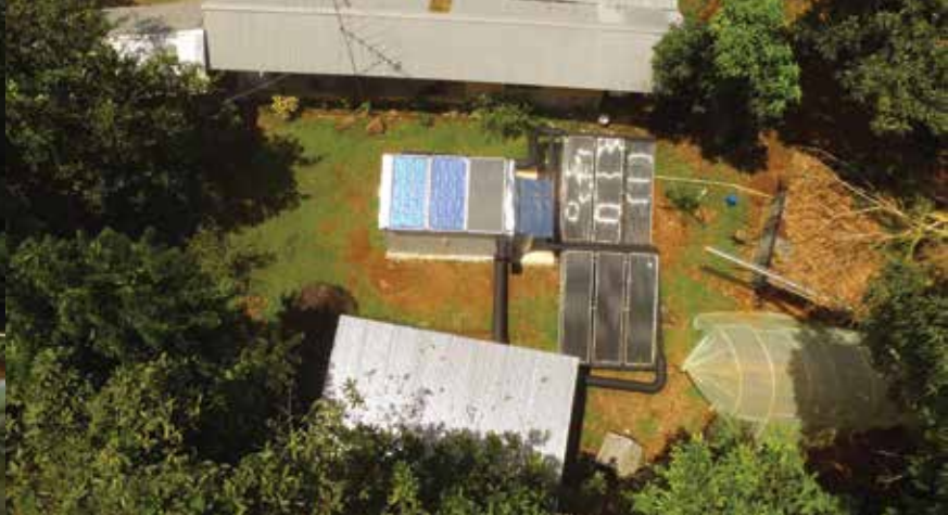
Figura 3. Sistema térmico solar híbrido forzado instalado en la Fábrica de Chocolates SIBAELI en Katira, Guatuso. (A) Sistema de colectores para el calentamiento de aire. (B) Vista aérea del sistema desde la que se puede observar, tanto los colectores para el calentamiento de agua como los colectores para calentamiento de aire.
