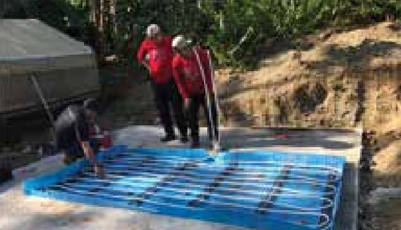
Figura 5. Colocación del piso radiante (A) en el sistema térmico solar híbrido forzado (B) instalado en la Fábrica Artesanal Chocolates Fusión.
