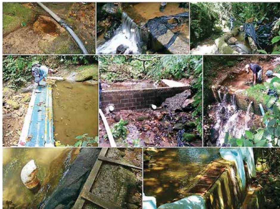
Figura 3. Estructuras hidráulicas de captaciones tipo superficiales.
