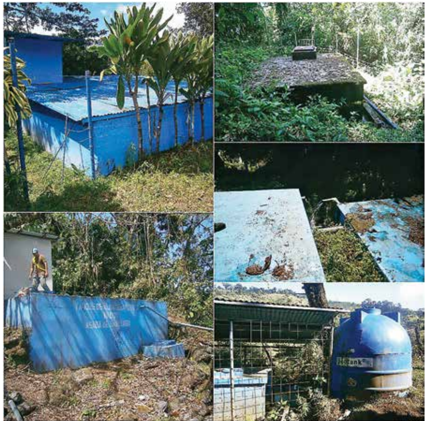
Figura 4. Estructuras hidráulicas de almacenamiento de agua en los acueductos.
