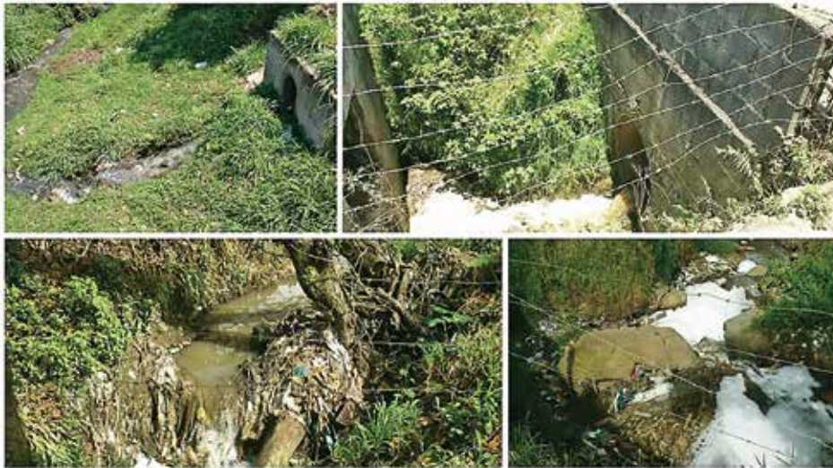
Figura 6. Vertimientos de aguas residuales y residuos sólidos a quebradas.
