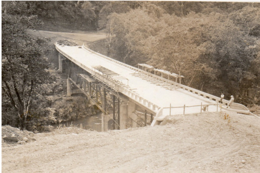
Figura 12. Puente actual, en la etapa final de su construcción. Fuente: Archivo Municipalidad de Turrialba
