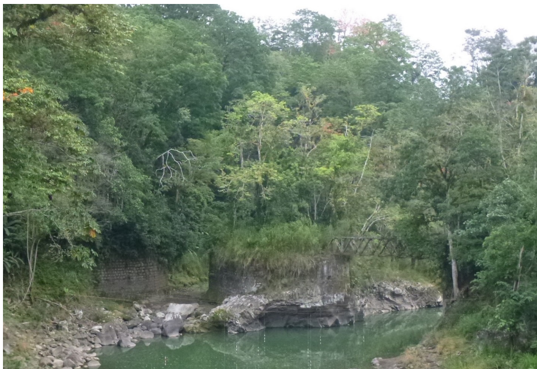
Figura 6. Paraje donde Kurtze construyó el puente. Nótense los bastiones erigidos sobre la roca central y las de ambas riberas. Fuente: Luko Hilje
